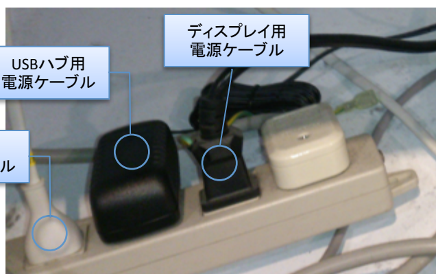
2号機 コンセント周り
